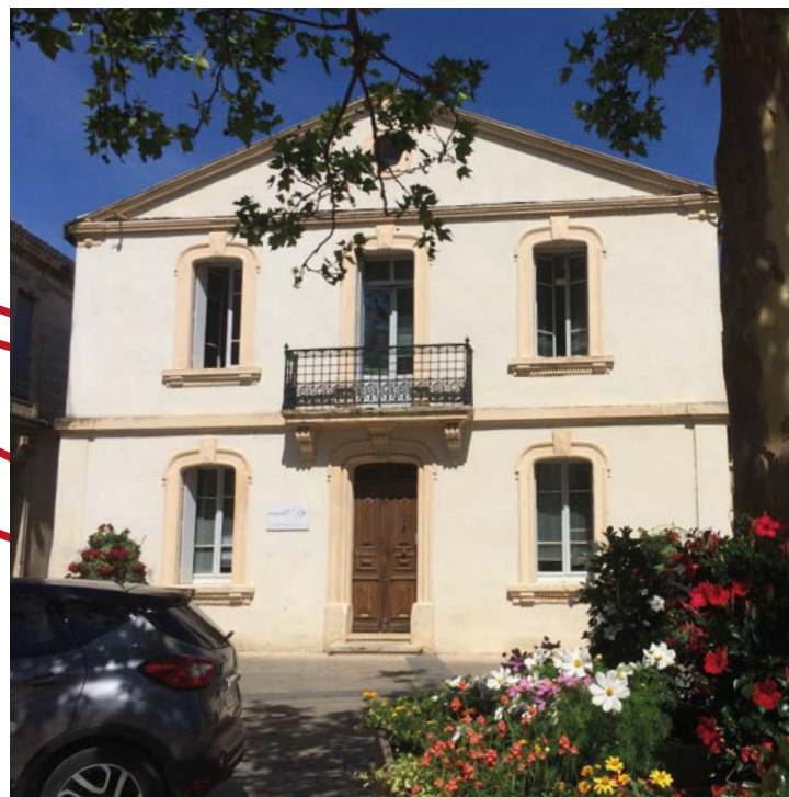
▲ Les bureaux de l'Or Aménagement
